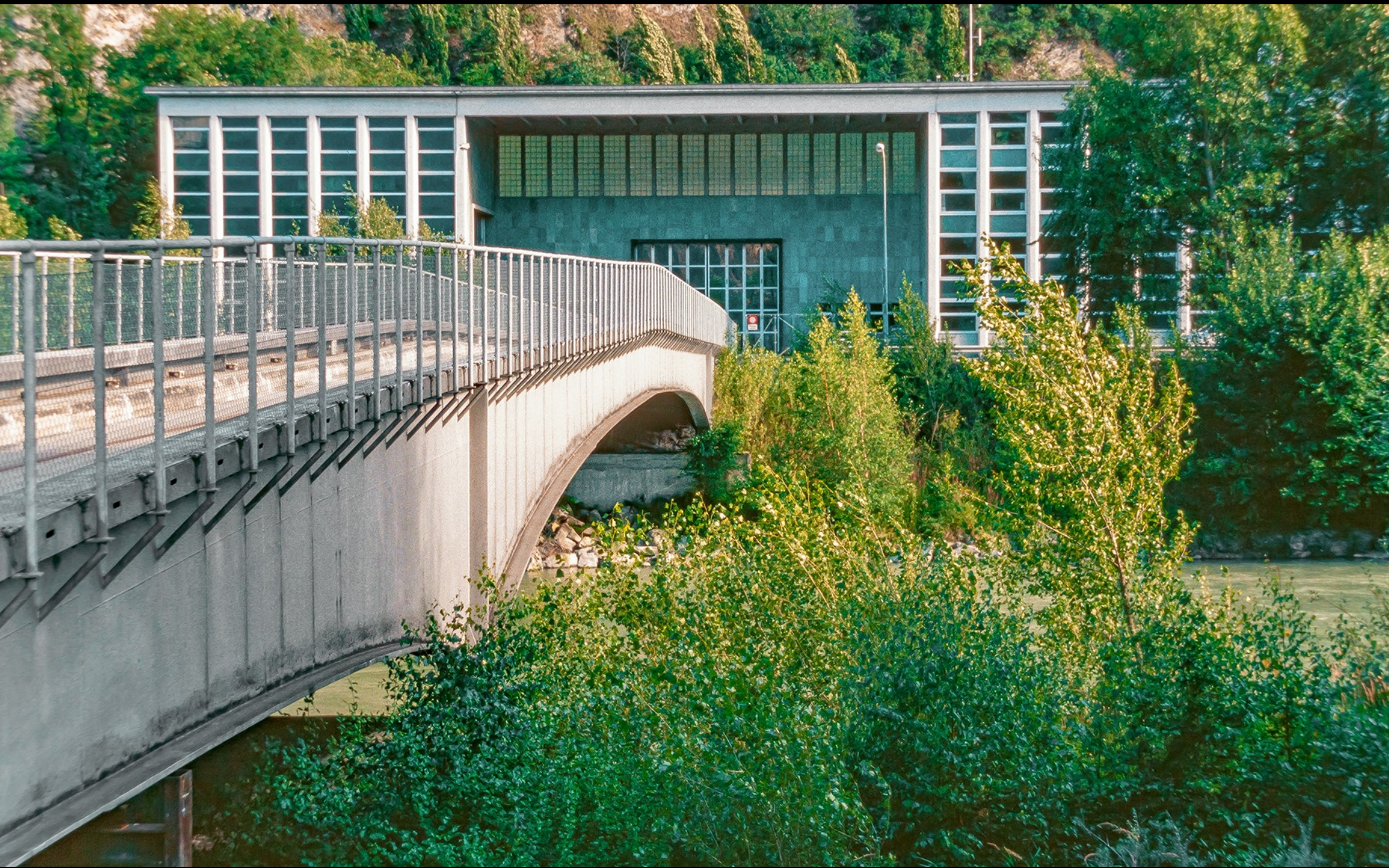
Das Kraftwerk Bieudron liegt im Innern des Berges. Die Druckleitung verläuft direkt vom Stausee zum Kraftwerk. Die Höhendifferenz beträgt 1883 m. Das führte im Jahr 2000 zu einem Rohrbruch, der drei Personen das Leben kostete. Sie wurden mitsamt den Berghütten vom Wasser weggefegt.
