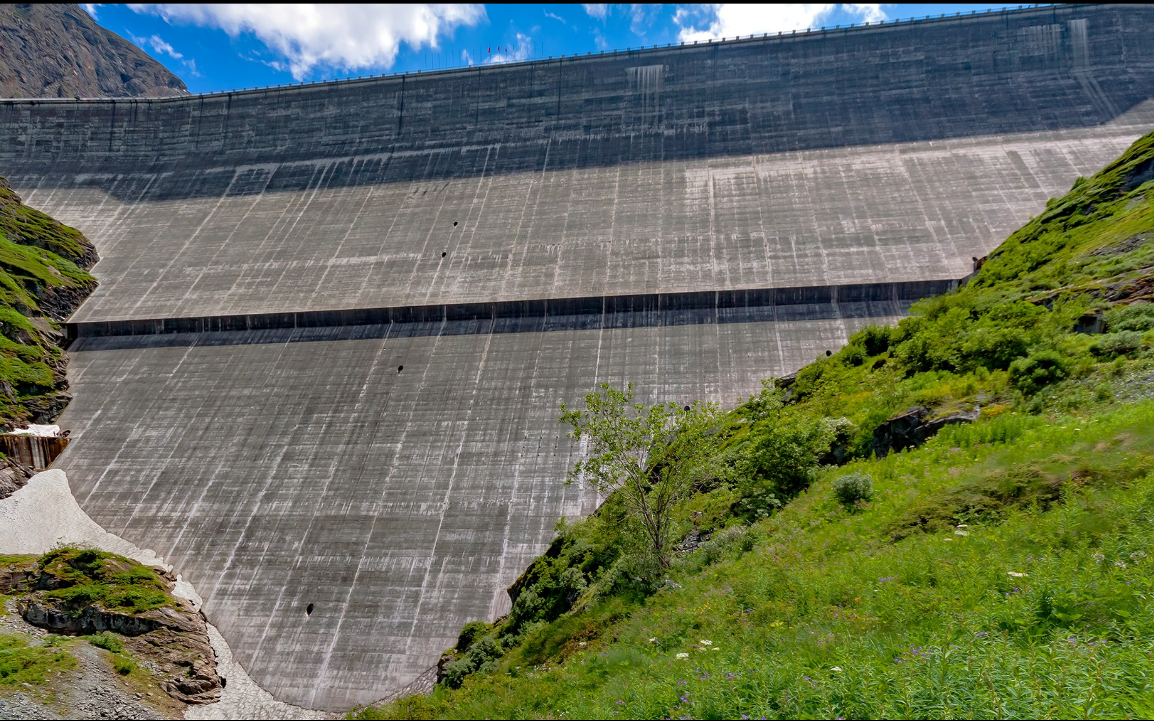
Die höchste Gewichtsstaumauer der Welt ist 285 m hoch und besteht aus fast 6 Millionen Kubikmeter Beton. Die Mauer ist an der Basis 200 m dick, die Mauerkrone ist noch so breit wie eine Autobahn. Sie ist mit einem Netz von Kontrollgängen und Treppen durchzogen.
