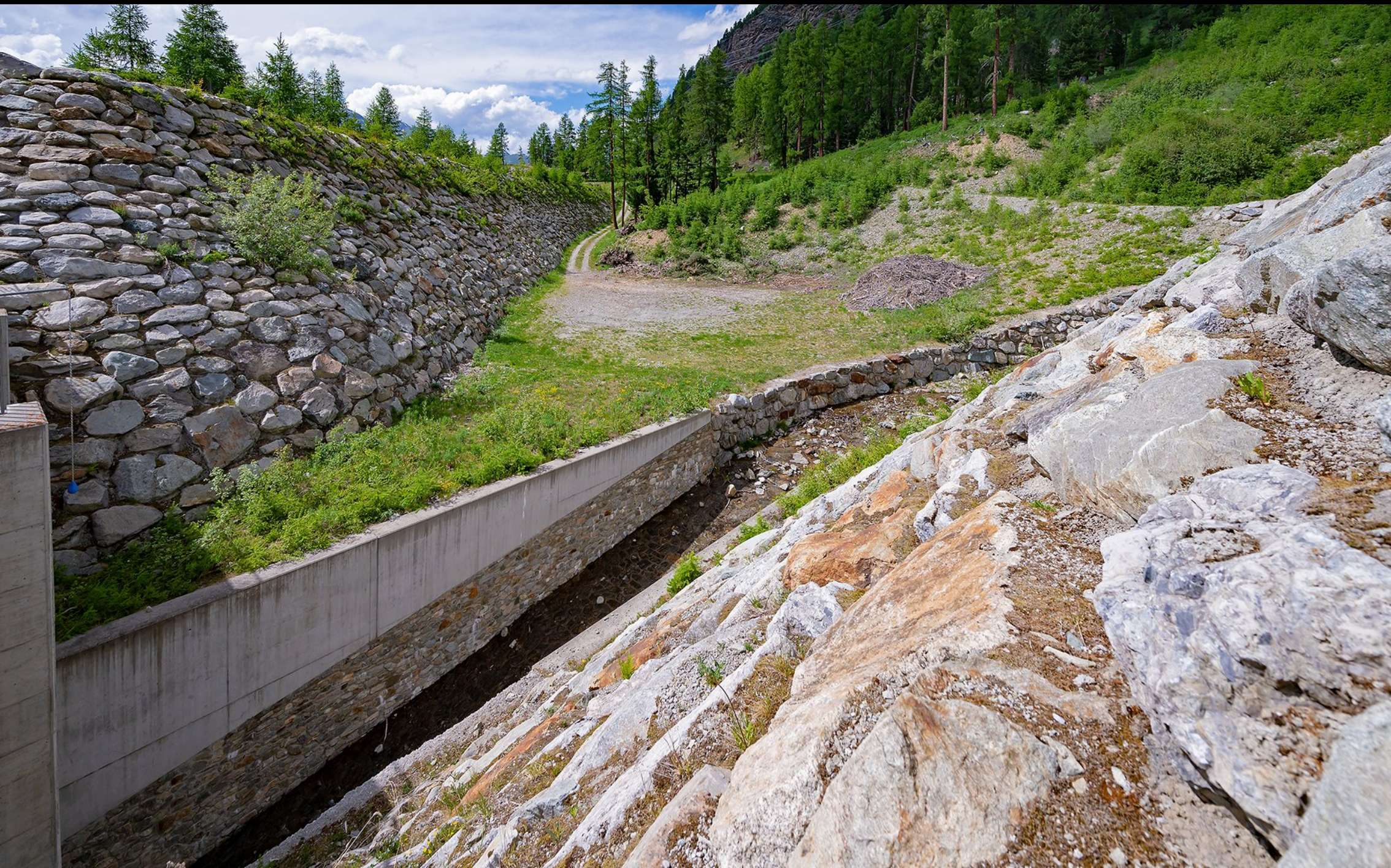
An manchen Orten der Alpen ist es der auftauende Permafrost, der Bergstürze auslöst. Eine der gefährlichsten Stellen ist der Berg «Las Suors», ein Nachbar des Piz Languard . Damit die Felsbrocken nicht das Dorf Pontresina zerstören, wurde 100 m über dem Dorf ein massiver Schutzdamm errichtet. 89
