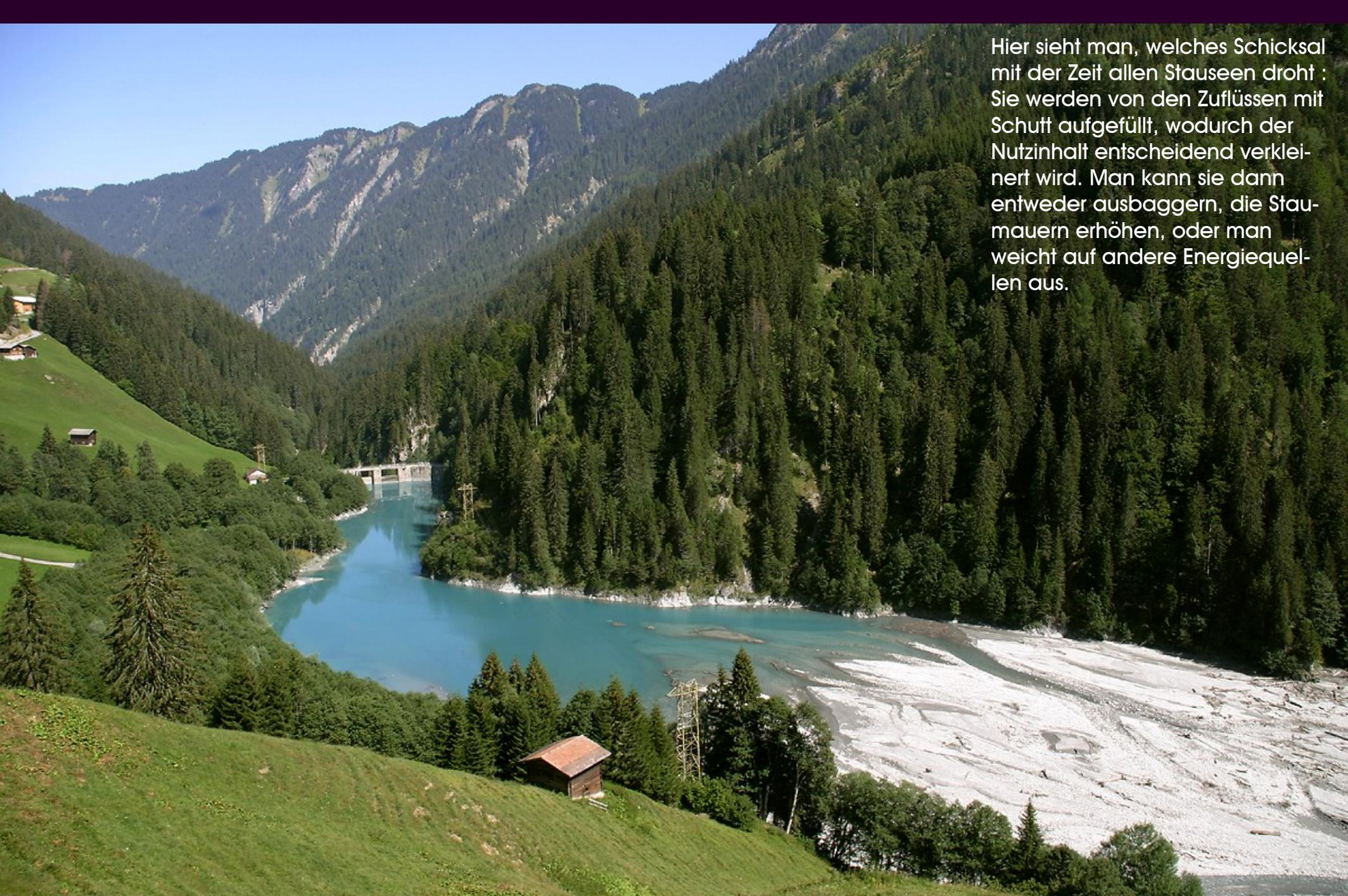
Hier sieht man, welches Schicksal mit der Zeit allen Stauseen droht : Sie werden von den Zuflüssen mit Schutt aufgefüllt, wodurch der Nutzinhalt entscheidend verkleinert wird. Man kann sie dann entweder ausbaggern, die Stau-mauern erhöhen, oder man weicht auf andere Energiequellen aus.
