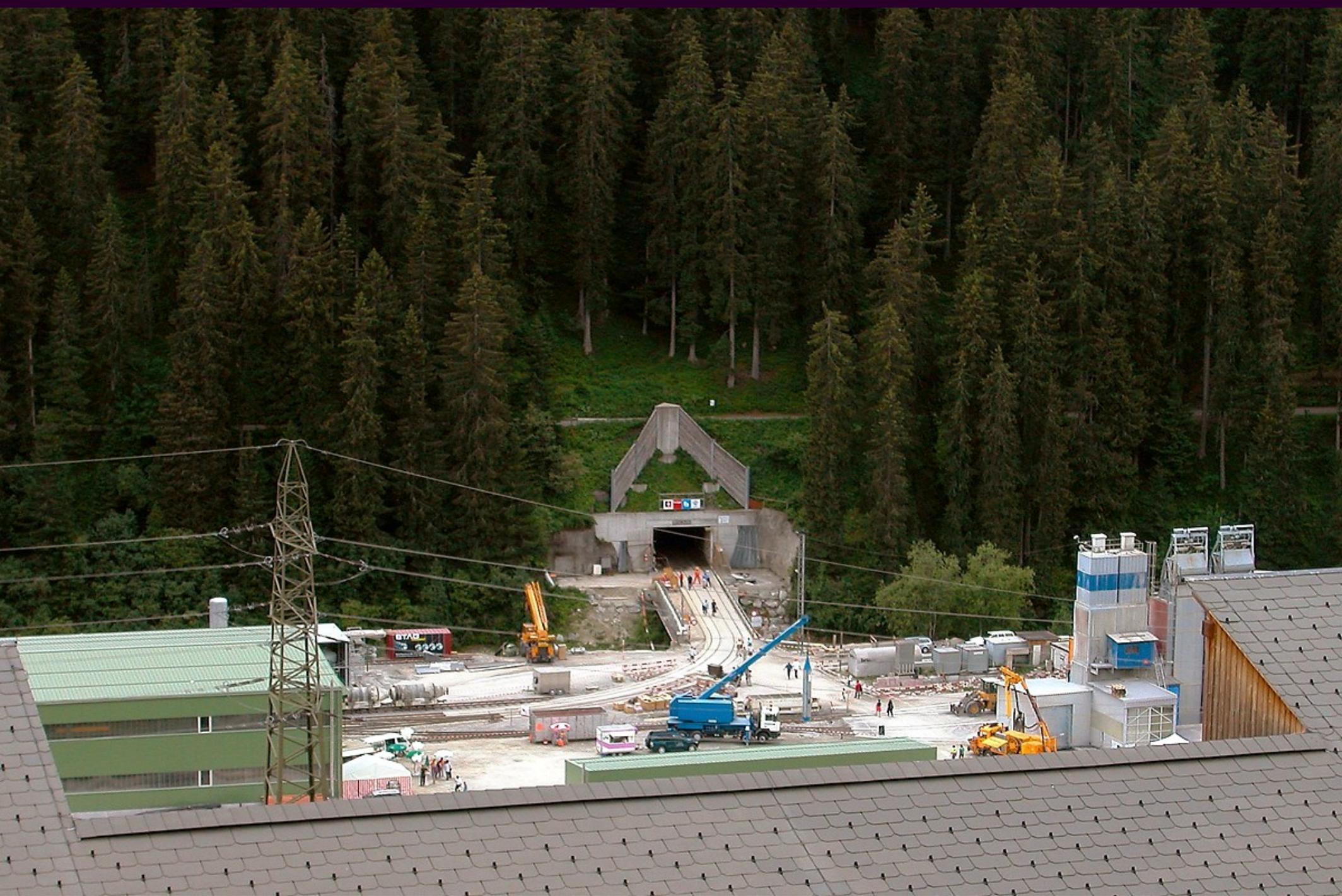
57 Kilometer lang soll dieser Gotthard-Basistunnel werden, also der längste Tunnel der Welt. Ganz unten am Ufer des Vorderrheins führt ein fast horizontaler Stollen einen Kilometer weit in den Berg. Am Tag der offenen Baustelle darf jeder hinein spazieren, der sich für dieses Bauwerk interessiert.
