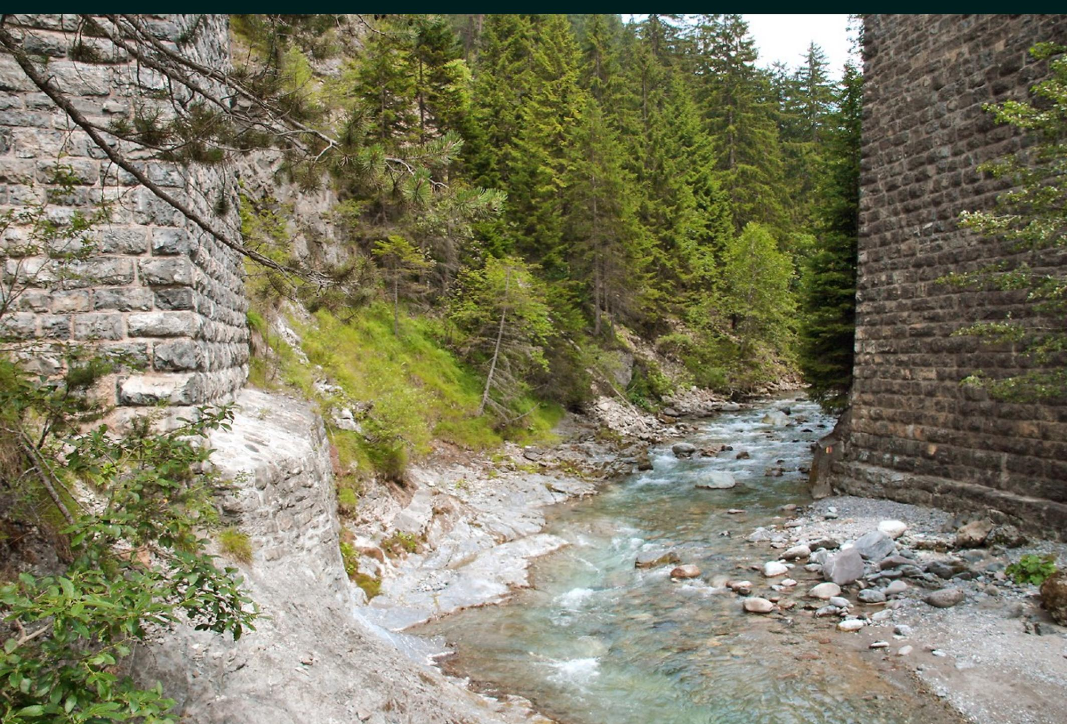
Die mächtigen Pfeiler des Viadukts sind auf festem Fels oder tief im Flussbett verankert. Dass das Landwasser nur so wenig Wasser führt, liegt an den ALK - Kraftwerken ([S. 76](#)); das Wasser wird bei Davos Glaris gefasst und fließt beim Kraftwerk Filisur in die Albula.
