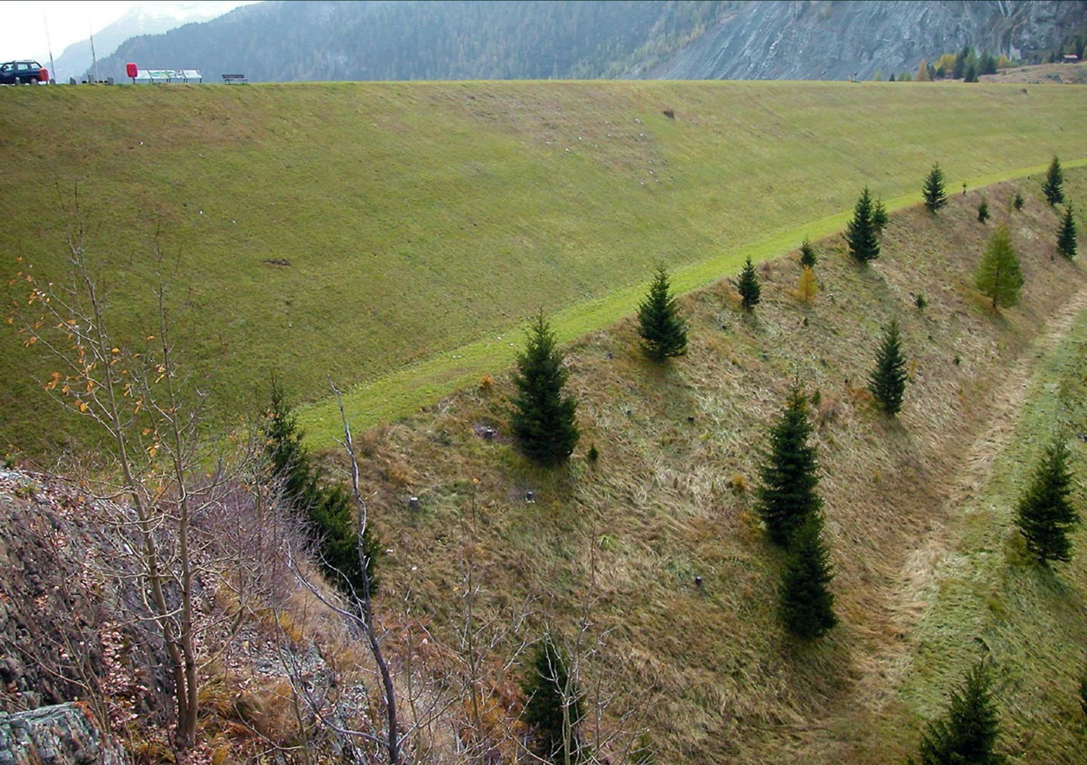
Der Marmorera-Stausee wird nicht durch eine Mauer, sondern durch einen Damm aufgestaut. Der See fasst  $62,8 \text{ m}^3$  Wasser, die Gesamtleistung der Kraftwerke Mittelbünden entspricht einem Fünftel des Kernkraftwerks Gösgen.
