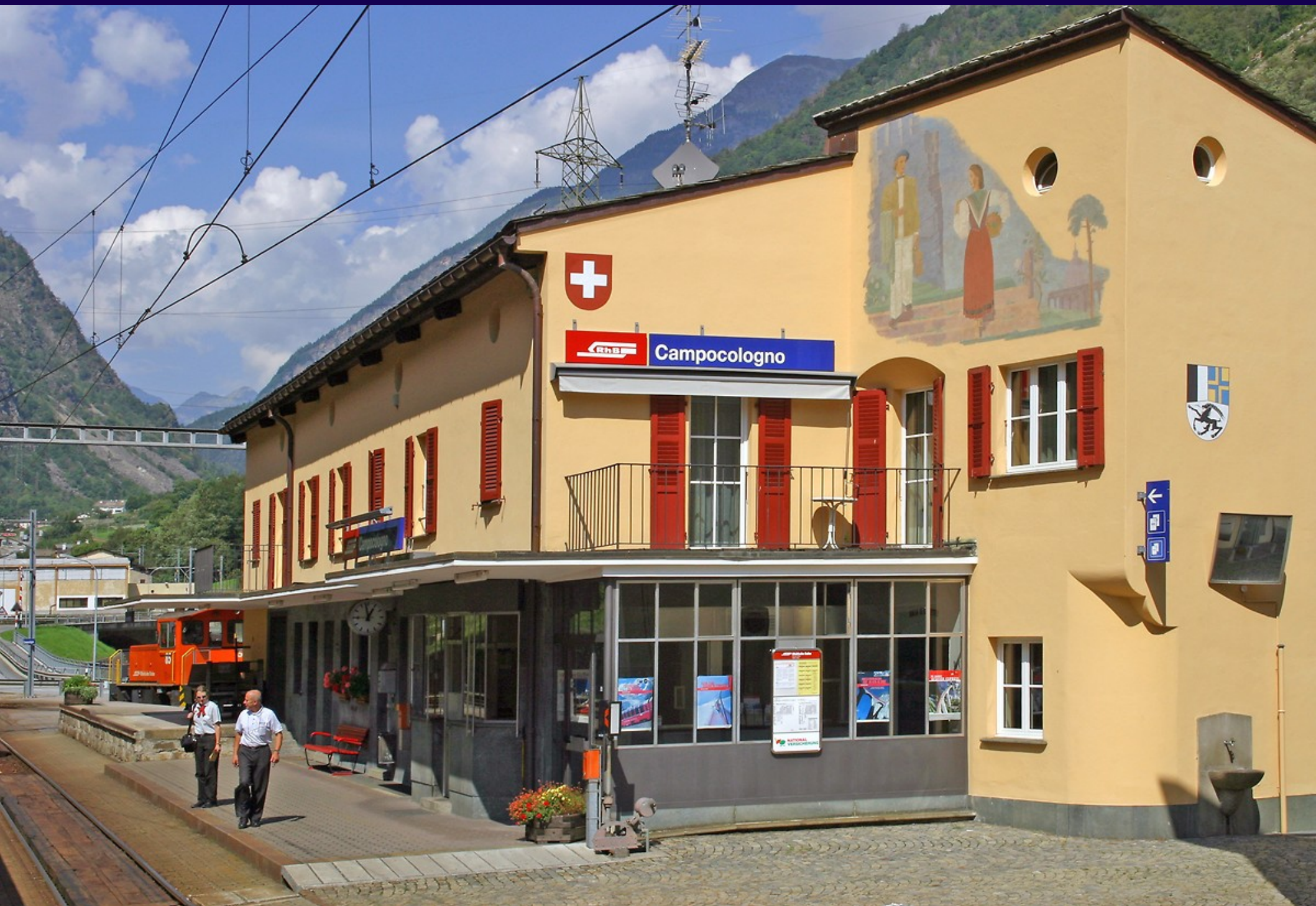
Campocologno ist der Grenzbahnhof zwischen der Schweiz und Italien. In wenigen Minuten wird der Zug in Tirano ankommen. Hier befindet sich auch das Kraftwerk, das mit dem Wasser des Lago di Poschiavo elektrischen Strom erzeugt.
