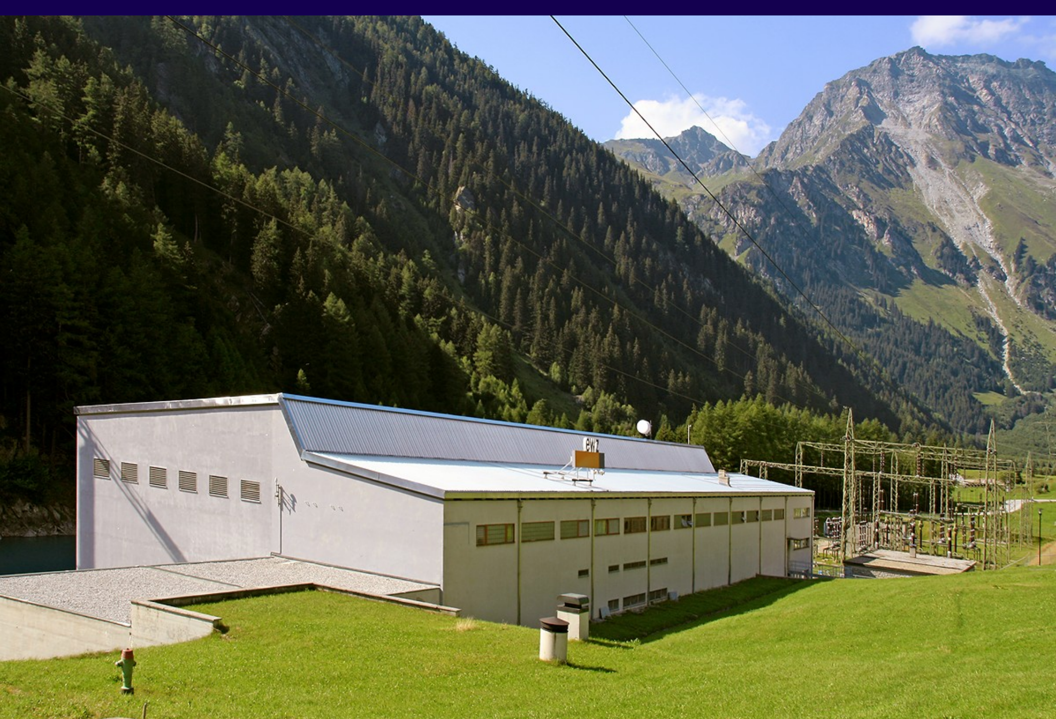
Dies ist das Kraftwerk Löbbia. Es steht am untern Ende des Talbodens von Casaccia . Hier wird aus dem Wasser des Forno- und des Albignagletschers Strom für die Stadt Zürich gewonnen.
