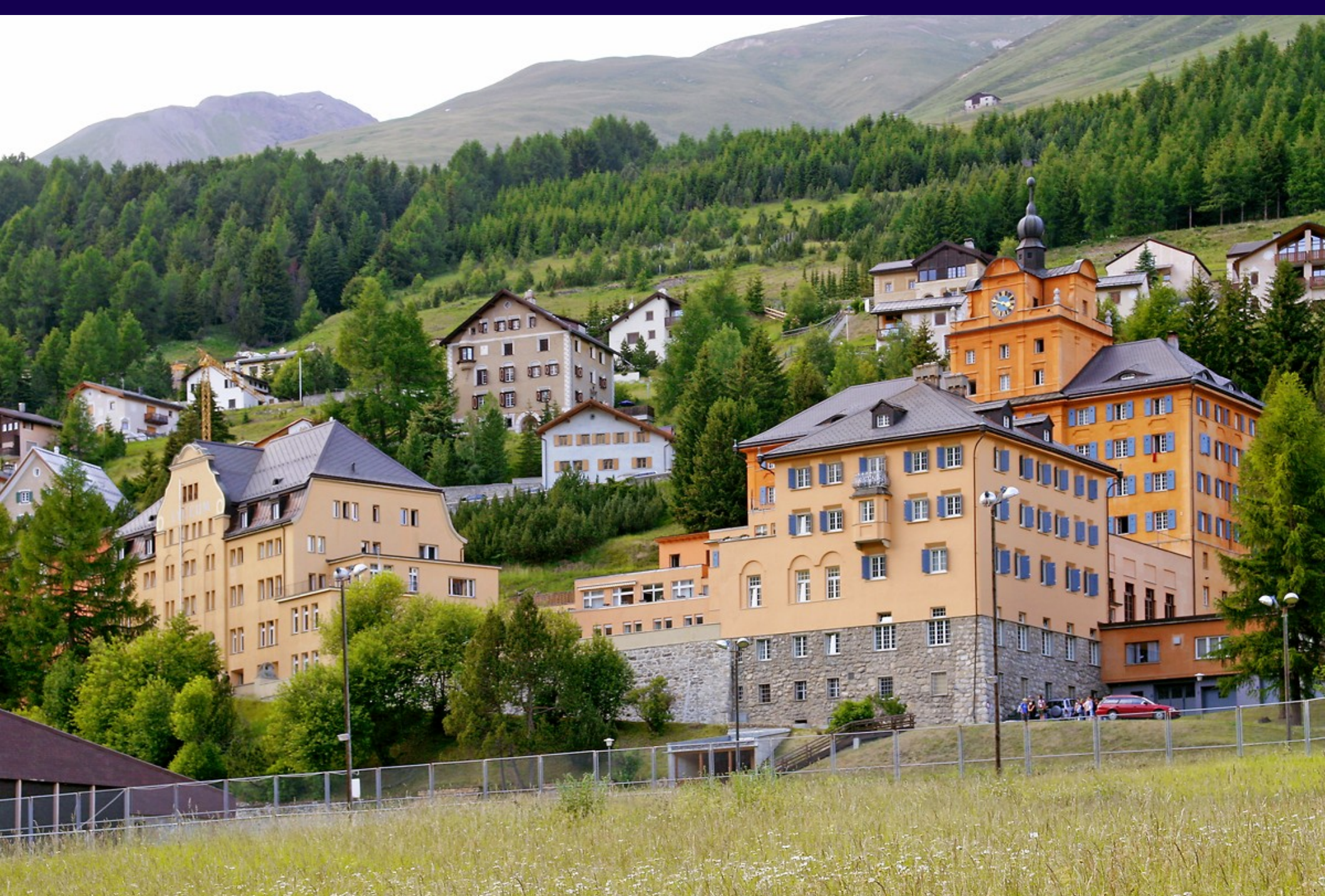
Die grösste Privatschule des Engadins, das Lyceum alpinum in Zuoz , wurde ursprünglich für reiche Söhne aus aller Welt gegründet. Es bietet 220 Unterkünfte für Internatsschüler und -innen. Weiter links stehen noch mehr dazu gehörende Gebäude, auch modernere Bauten.
