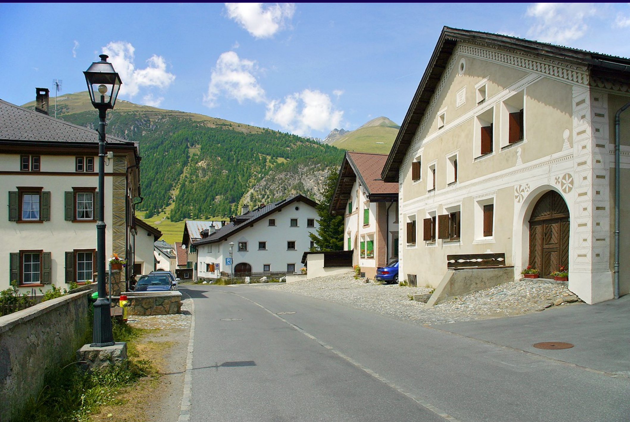
Längs der Dorfstrasse des Dorfteils Chamues-ch stehen gut erhaltene Engadiner Häuser.
