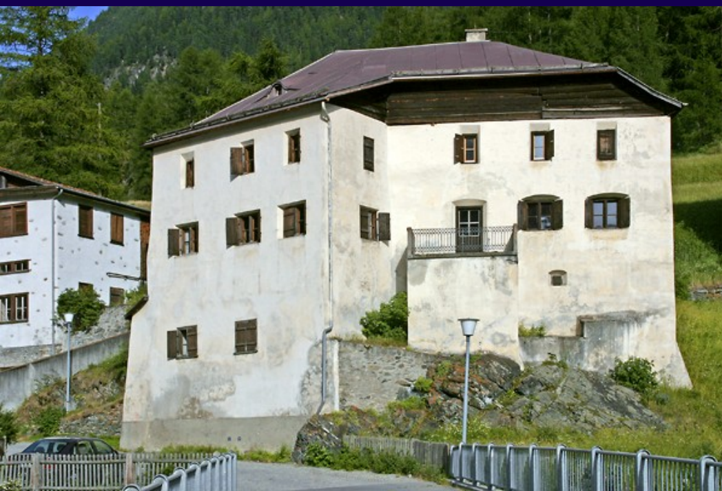
Sehr altes Haus bei der Brücke von Susch
