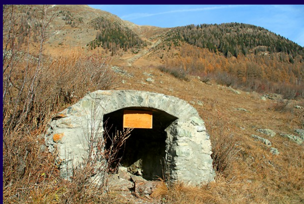
Neue Tal- strasse
