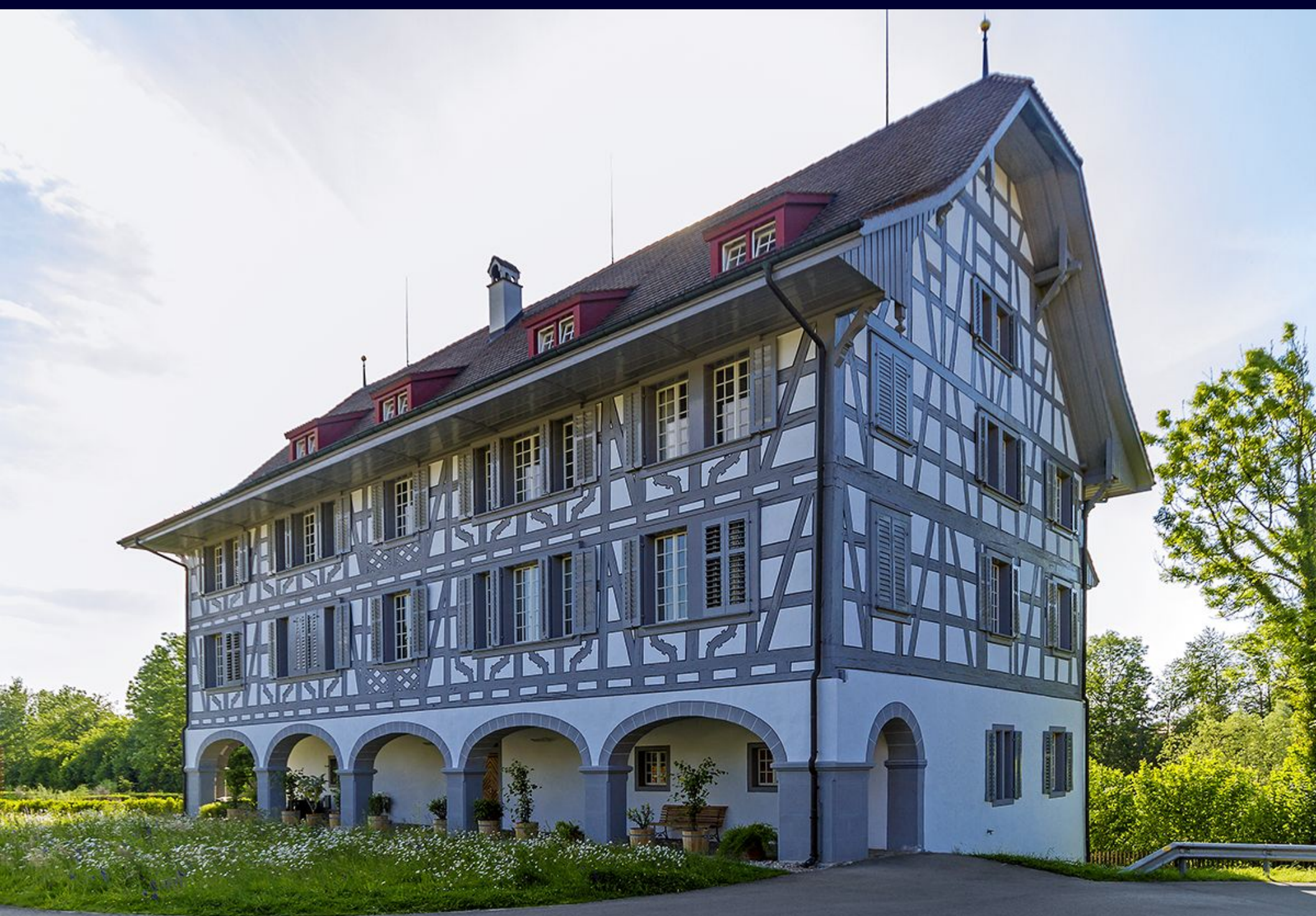
Dieses prächtige Fachwerkhaus steht ausserhalb des Klosterareals; es ist ein Nebengebäude des ehemaligen Klosters Rathausen.
