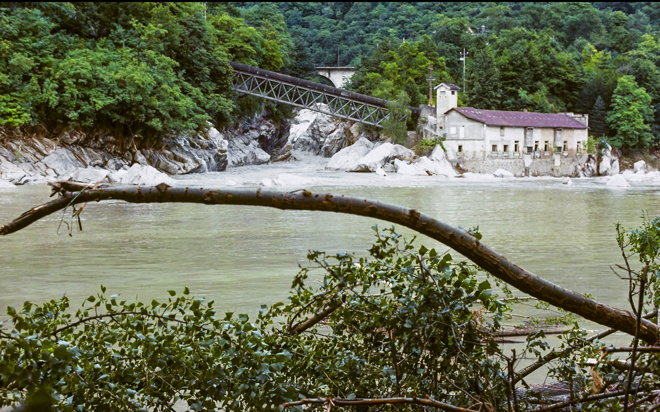
Nach der Schlucht von Ponte Brolla macht die Maggia eine Spitzkurve von etwa 120^\circ nach links (im Bild nach rechts). Das extreme Hochwasser schaffte die enge Kurve nicht und zerstörte den Campingplatz, an dessen Rand ich hier stehe. Das Kraftwerk rechts wurde zwar nass, aber nicht beschädigt. 22
