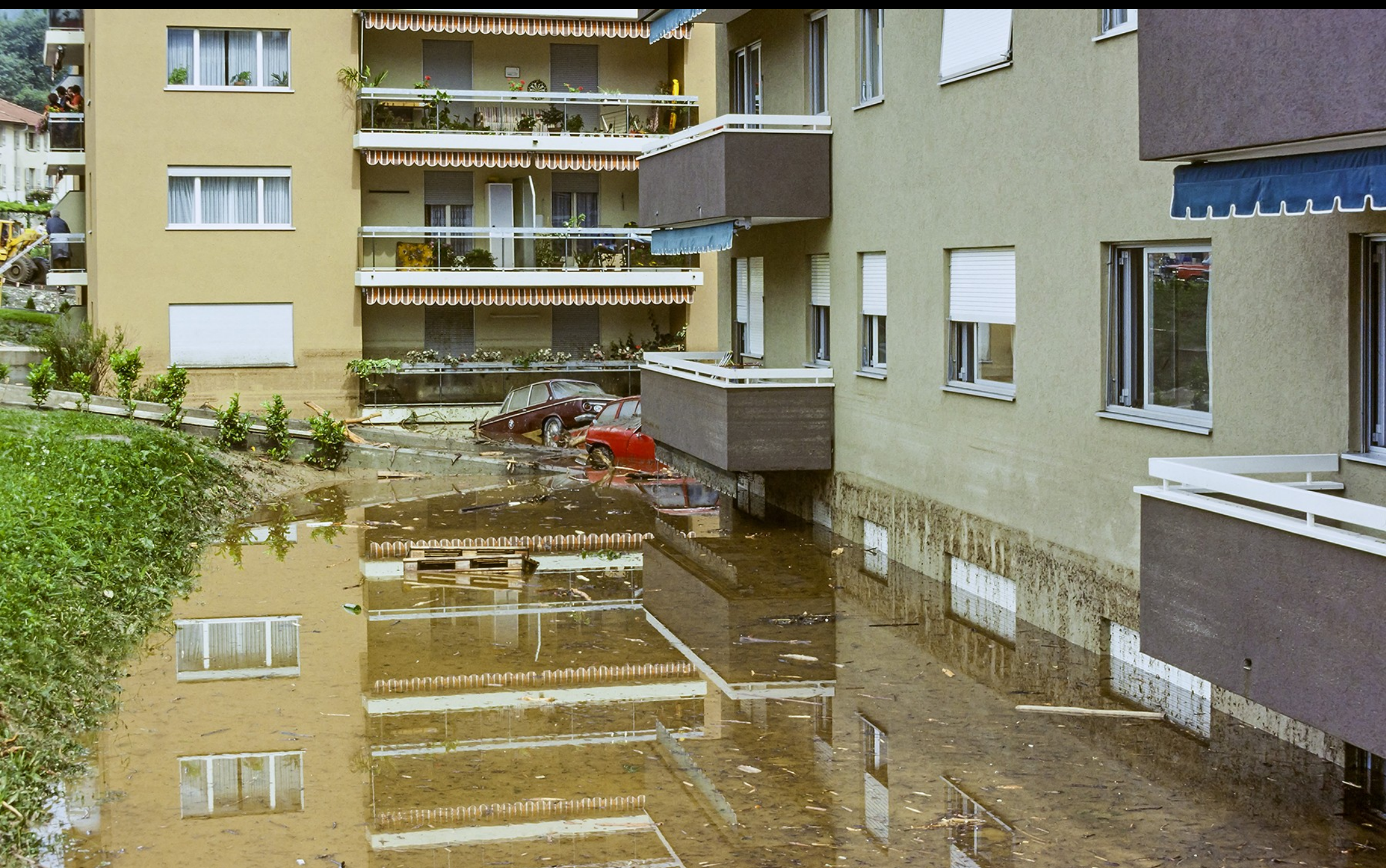
Der Wasserspiegel sinkt, das unterste Stockwerk kommt zum Vorschein. Der Parkplatz zwischen den Häusern hat wohl auch etwas abbekommen.
