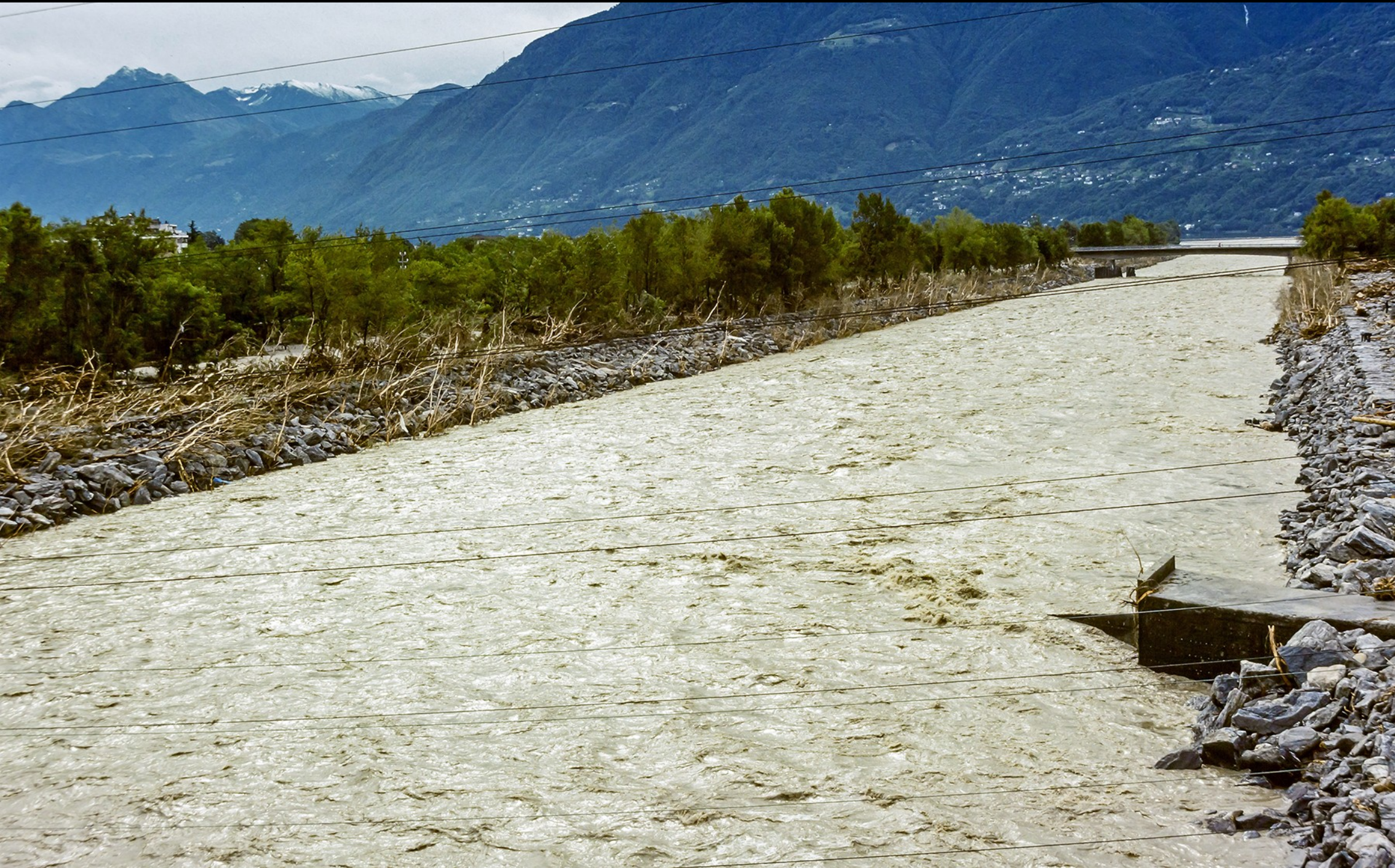
Die hoch gehende Maggia strömt über das Delta dem Lago Maggiore zu. Auf beiden Seiten sind starke Hochwasserdämme, die jedoch in der Nacht zum 8.8.1978 gnadenlos überflutet wurden. Der Fluss soll in der Nacht etwa 4'500 \text{ m}^3 Wasser pro Sekunde geführt haben.
