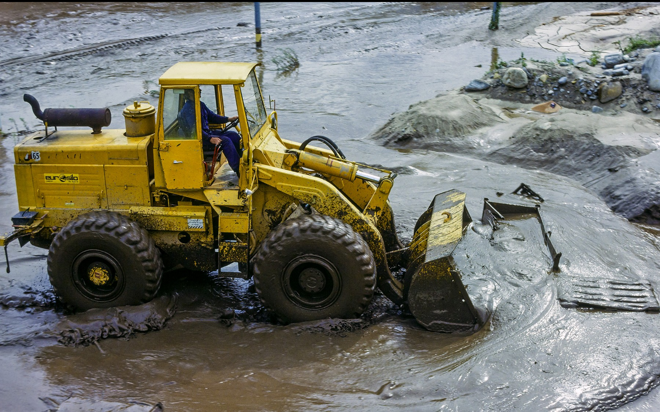
Nach der Schreckensnacht wird am Morgen aufgeräumt – wenigstens wird es versucht. Die Maggia hat sich zwar zurückgezogen, aber sie hat einiges zurück gelassen : Schlamm, Baumstämme, Geröll und Schäden an Bauten und Fahrzeugen. Sehen wir uns um.
