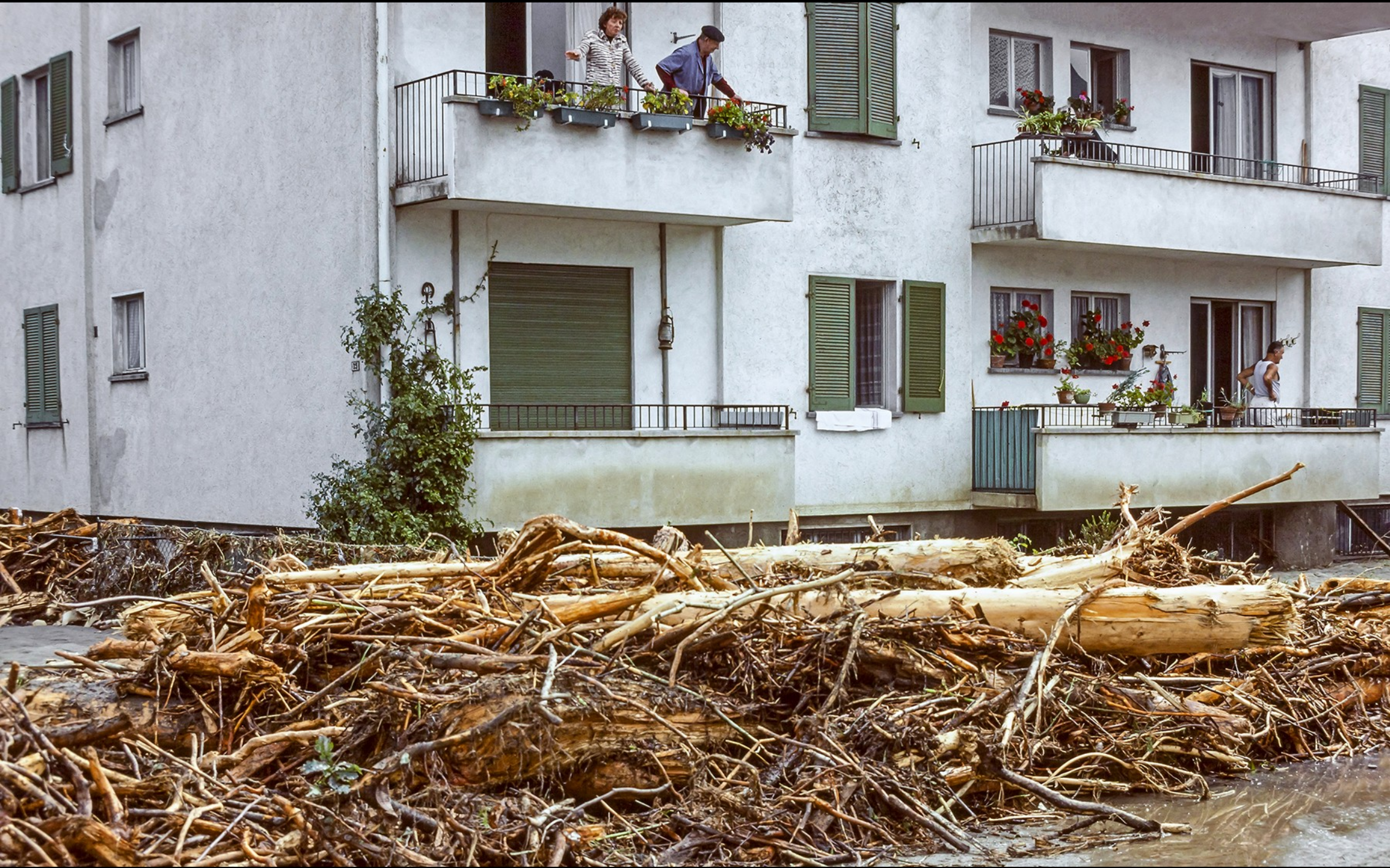
Bei näherer Betrachtung sehen wir, wie hoch das Wasser in der Nacht gereicht hatte. Die untere Wohnung hat wohl noch etwas Wasser abbekommen. Aber darunter ist ein weiteres Stockwerk mit Wohnungen ! Und die standen bis zur Decke unter Wasser. Die Bewohner mussten nach oben flüchten. 10
