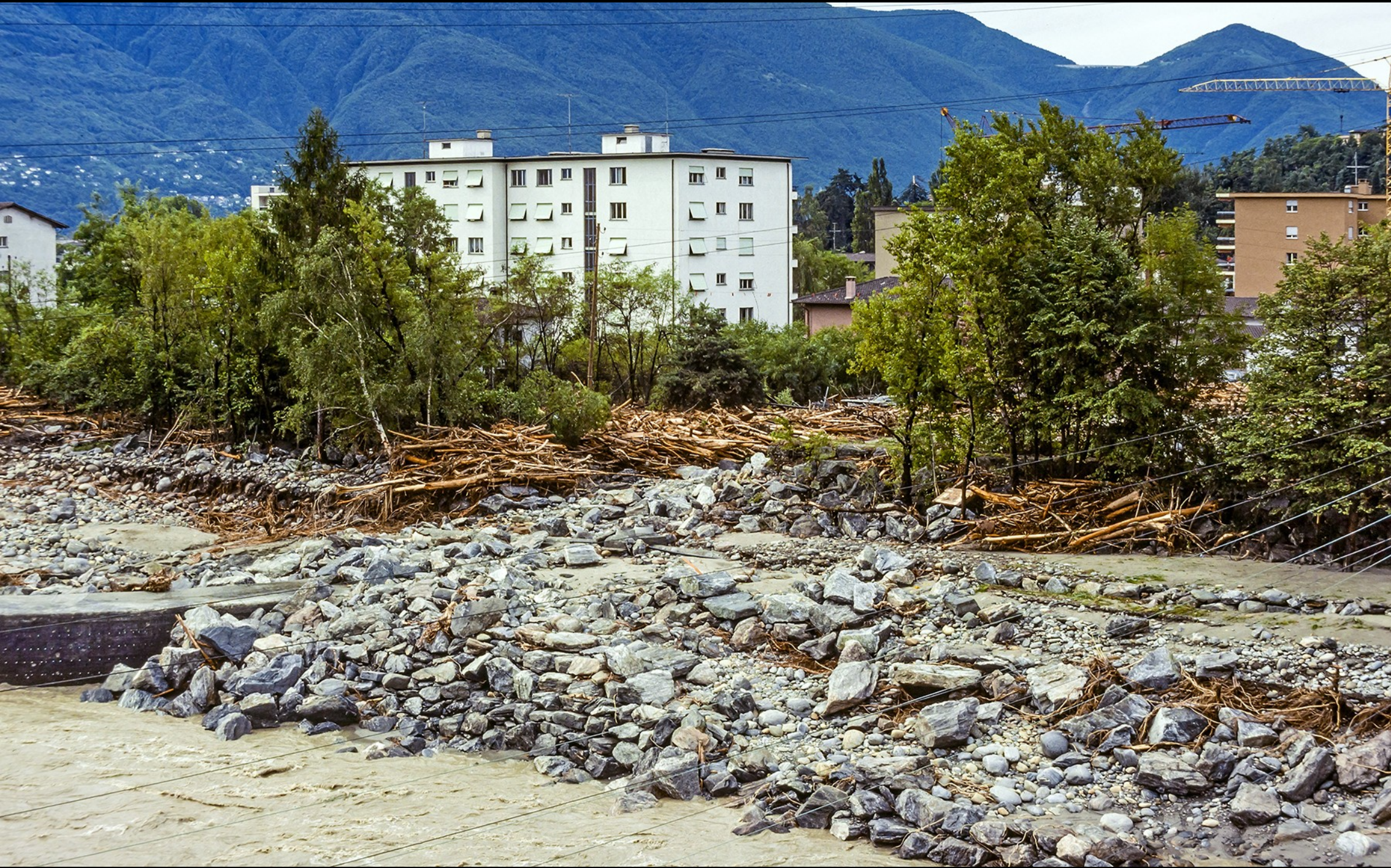
Auf der rechten Seite bei Ascona ist der Damm durch eine Baustelle unterbrochen. Durch diese Lücke ist die Maggia , beladen mit Unmengen von Baumstämmen, ins tief gelegene östliche Neubauquartier eingebrochen. Woher die vielen Bäume kommen, werden wir später noch sehen.
