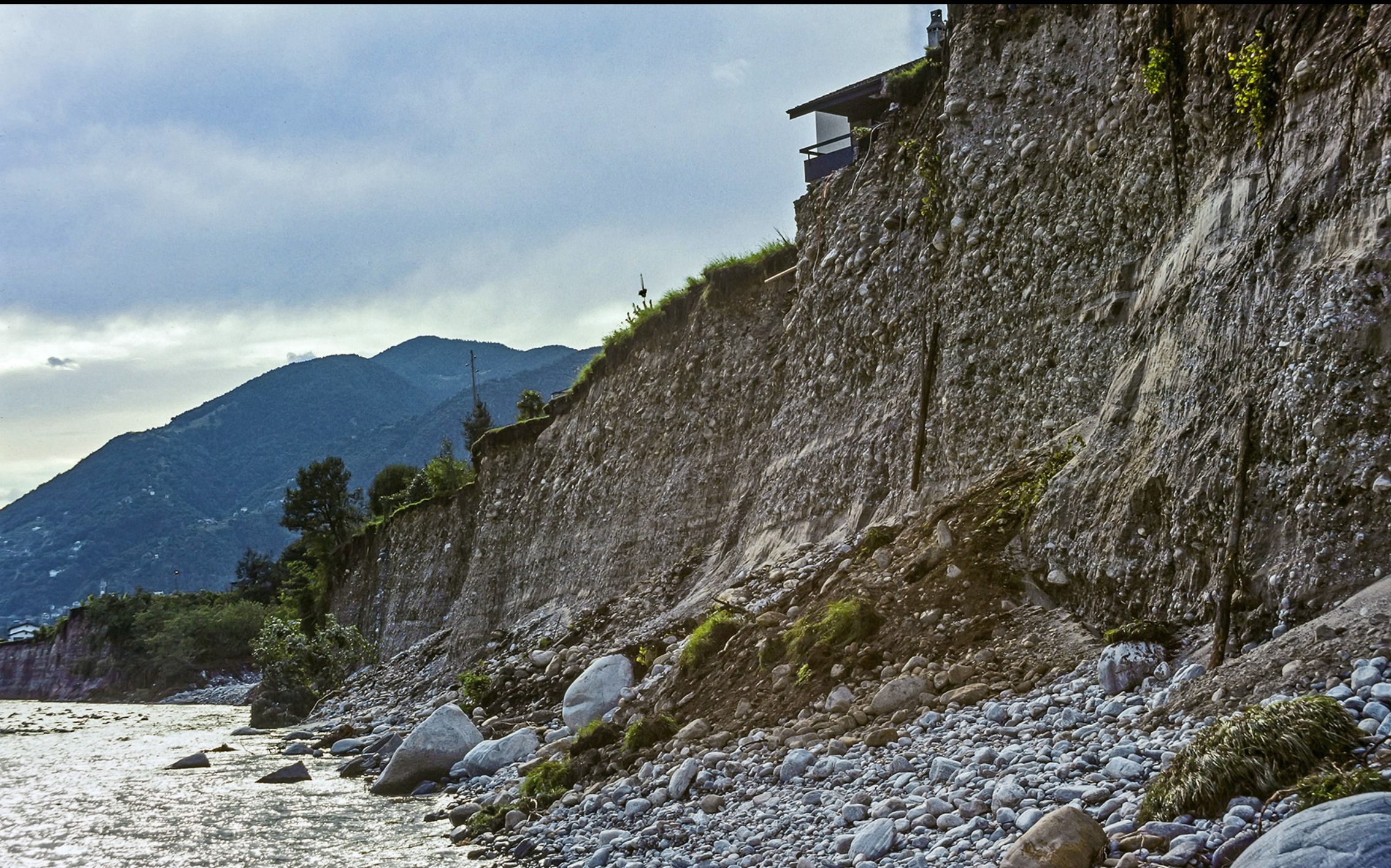
Die Melezza hat über Nacht ihr Flussbett massiv verbreitert und anschliessend weiter nach Süden verlegt. Diese senkrechte Wand war zuvor ein Abhang. Schon früher mussten hier gewaltige Überschwemmungen vorgekommen sein, denn der Boden besteht aus altem Flussgeröll. Darunter liegt neues. 19
