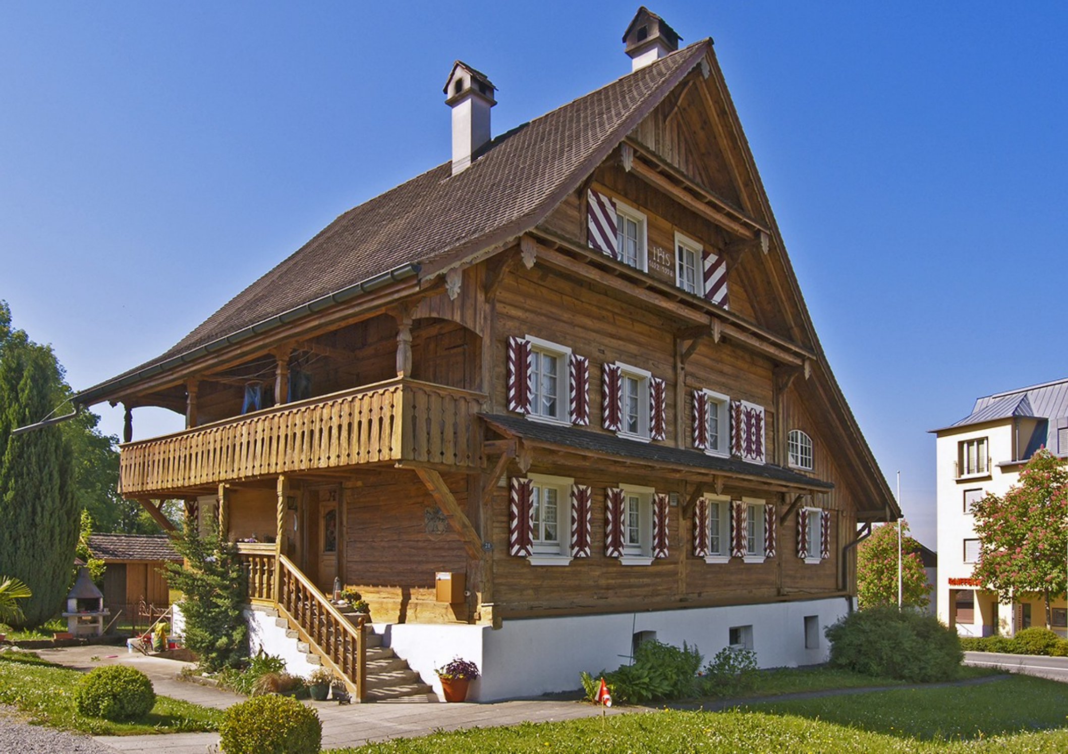
An der Chamerstrasse nördlich vom Zentrum von Hünenberg steht dieses schön renovierte Holzhaus aus dem Jahr 1692.
