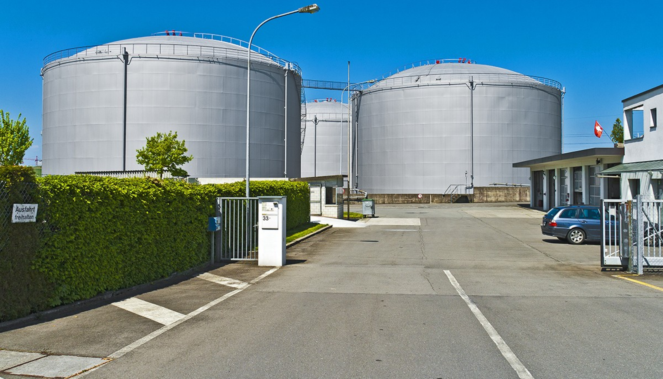
Am östlichen Ortsrand von Rotkreuz , wo sich im 19. Jahrhundert noch eine Mühle befand, steht heute ein grosses militärisches Brennstofflager mit einem eigenen Eisenbahnanschluss; hier wird Brennstoff für die Flugzeuge der Schweizer Armee bereitgestellt.
