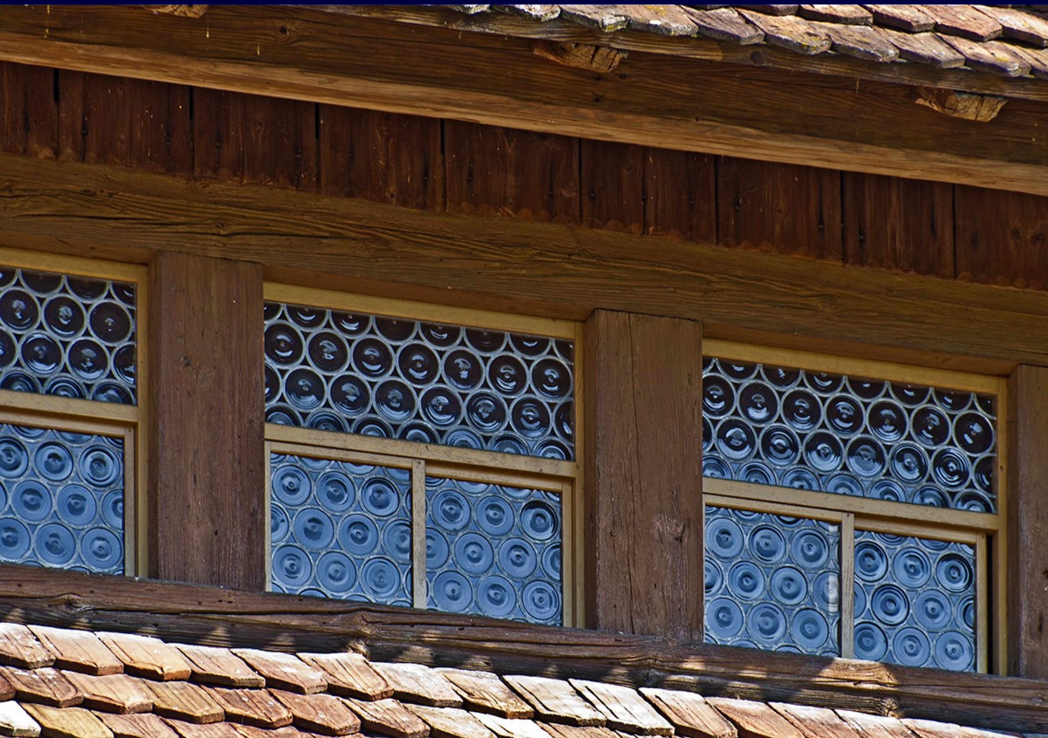
Im 15. und 16. Jahrhundert, als man noch keine ganzen Glasscheiben gießen konnte, wurden Butzenscheiben mit Hilfe von Bleifassungen zu Fensterscheiben zusammengesetzt. Diese Scheiben hier wurden wohl viel später gefertigt, was man den Rahmen ansieht. zurück 299
