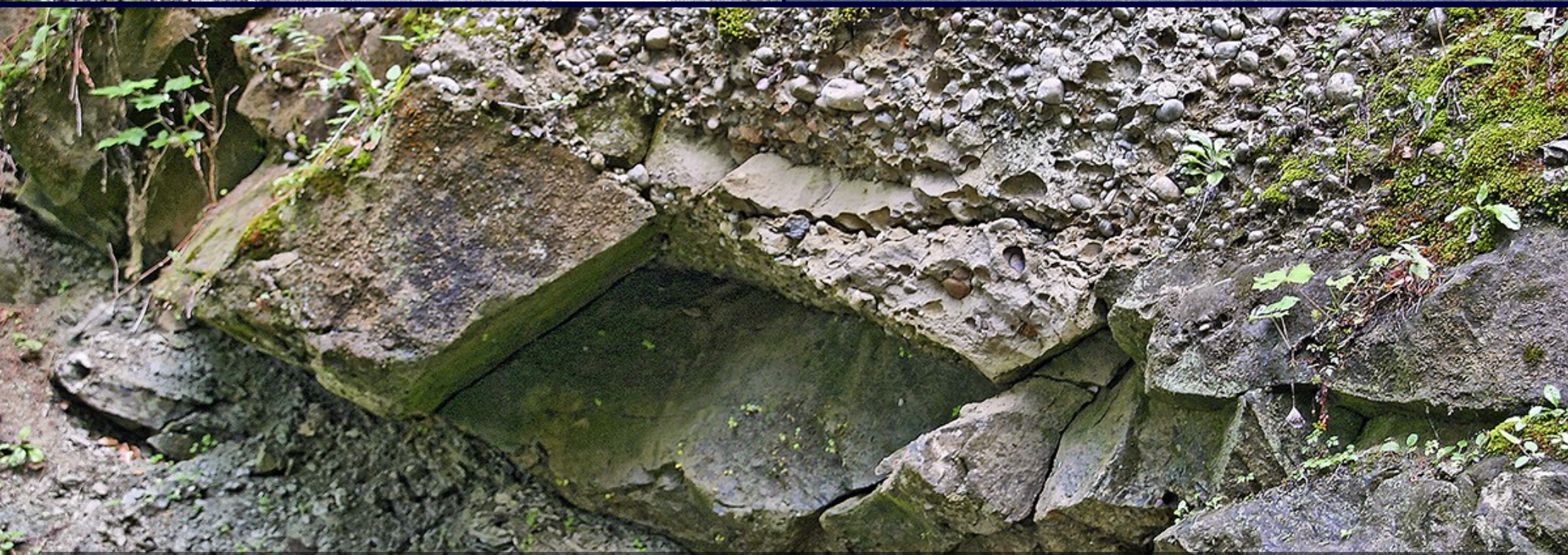
Auf der Nordseite des Gottschalkenbergs führt eine steile Drittklassstrasse nach Finstersee hinunter, durch schwieriges und sehr instabiles Gelände. Der Hang besteht aus Nagelfluh und Sandsteinen der Unteren Süsswassermolasse: Geröll und Sand der ersten Alpenhebung. In diesem Gebiet wurden von 1838 an und auch während des Zweiten Weltkriegs mehr als 400 Tonnen Braunkohle abgebaut.
