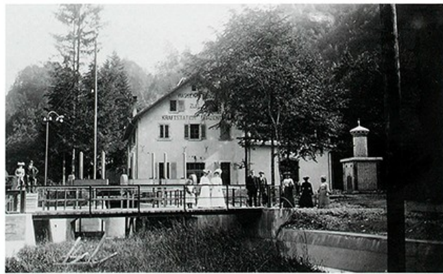
Das Turbinenhaus der Zentrale 1: Eine Turbine versorgte die Stadt Zug, die zweite die Metallwarenfabrik und die dritte die Spinnerei Boar.
