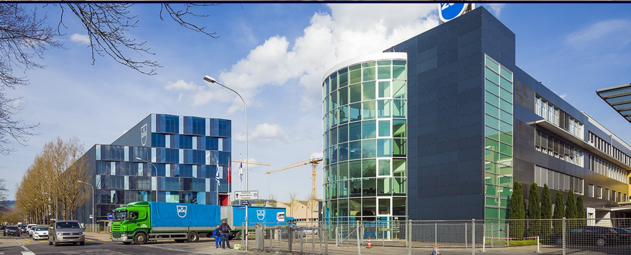
Oben : Ein kleiner Teil der Bauten von Siemens und Landis+Gyr ist hier zu sehen. Und es wird weiter gebaut. Unten : Das Verwaltungsgebäude der V-Zug steht mitten im Fabrikareal. Diese beiden Industriebetriebe sind die grössten der Stadt Zug.
