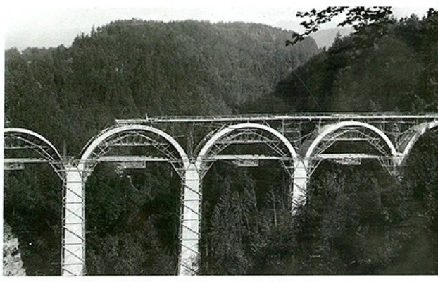
Die langgestreckte Verbindung von Berg und Tal: Lorzentobelbrücke von 1910 während der Bauarbeiten.
